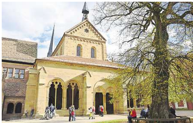
Die Maulbronner Klosterkirche erstrahlt nach den aufwendigen Sanierungsarbeiten pünktlich zum Festgottesdienst in neuem Glanz.
